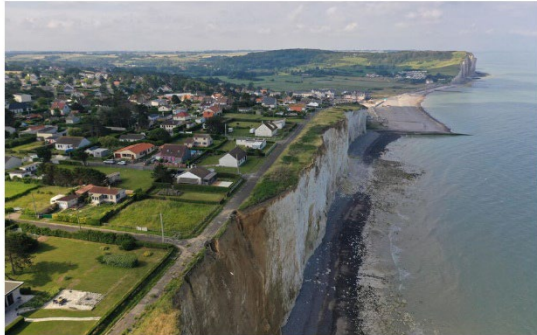
À Criel-sur-Mer (Seine-Maritime), la falaise est victime de l'érosion côtière. Pourtant, la demande immobilière est toujours importante. AFP/Damien Meyer
